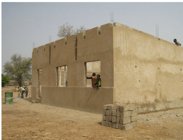
Abril 2007. Les obres ja estàn en marxa.
