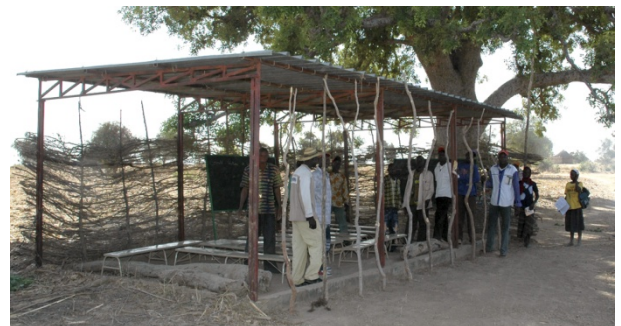
Estructura aproximada que demanen.
