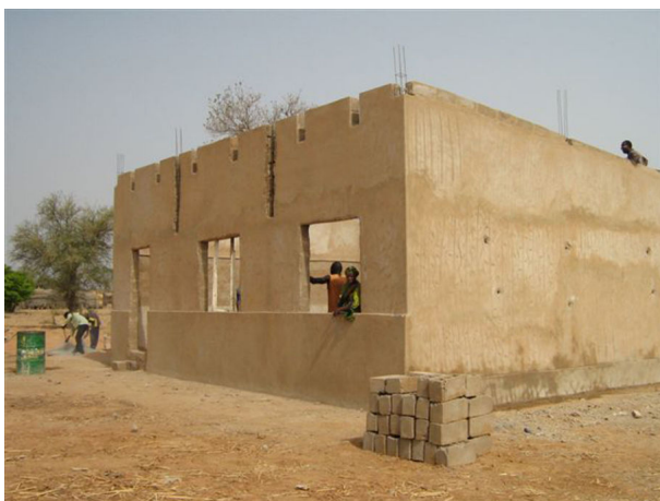
Abril 2007. Les obres ja està en marxa.
